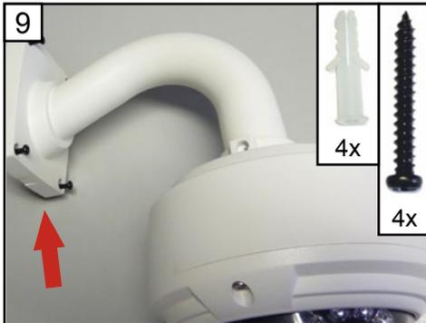
Ziehen Sie die Kabel durch die Wand. Befestigen Sie den Wandhalter mit Hilfe der vier Dübel und der vier Schrauben M4x30 an der Wand.
